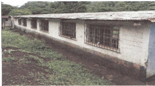
a) Mantenimiento de Balcones Metalico (Luado + pintado). b) Pintada de paredes Interior y Exterior de las 3 aulas y 1 Dirección.
