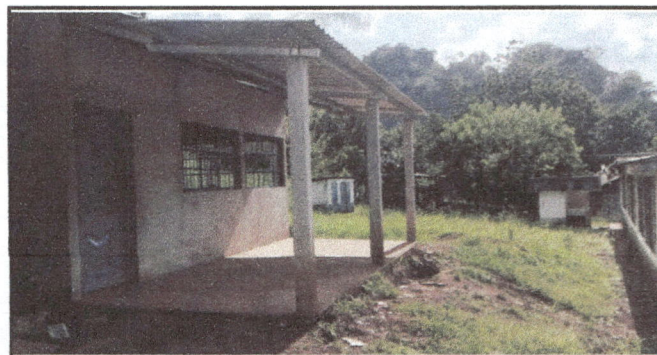
Pintada de paredes Interior y Exterior.
