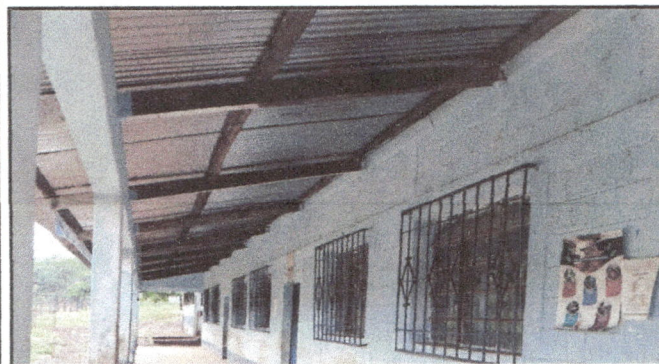
Cambio de Tijeras y Costaneras de madera por Tubo cuadrado 4X4 CH16 y Costaneras 2X3 CH16 Galvanizadas de las 3 aulas y 1 Dirección.
