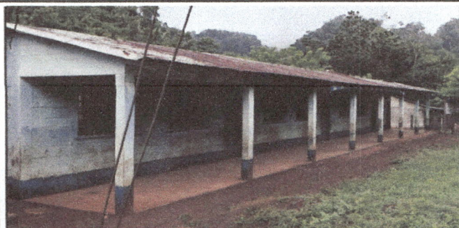
a) Cambio de láminas acanaladas por láminas troqueladas de las 3 aulas y 1 Dirección. b) Mantenimiento de Puerta metálica (Luado + Pintada). c) Sustitución de Chapa por Chapa Yale para puerta de aula.
