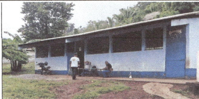
a) Cambio de láminas acanaladas por láminas troqueladas de las 2 aulas. b) Mantenimiento de Tijera y Costaneras (Luado + pintada). c) Pintada de paredes Interior y Exterior.
